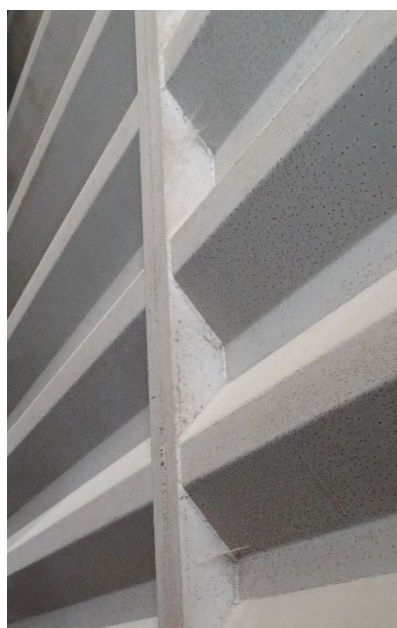
Montant en section U jumelée. Les parois en tôle trapézoïdale sont soudées de part et d'autre. © CTICM
