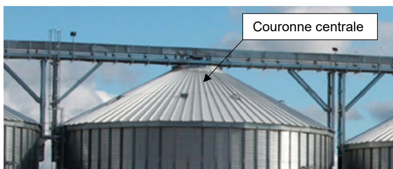
Toit « chapeau chinois » avec passerelle/ convoyeur. © Privé SA
